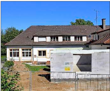
Blick auf den künftigen Anbau im Kindergarten Altdorf. Fotos: Ulrike Hiller
