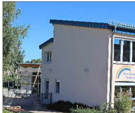
Auch der Kindergarten in Wallburg wird baulich erweitert.
