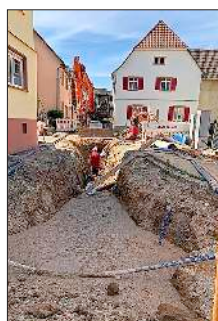
Die Kanalumbauarbeiten laufen. Die Fertigstellung der Arbeiten in der Muschelgasse ist im September geplant. Foto: Stadt Ettenheim
