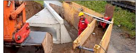
Die Verlegung des neuen Regenwasserkanals mit der Versetzung des 17 Tonnen schweren Einlaufteils am Ettenbach hat begonnen. Foto: Stadt Ettenheim
