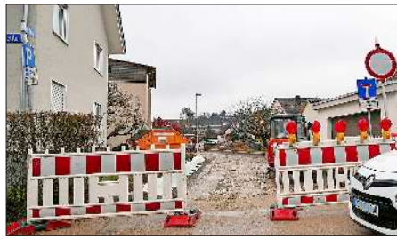
Die Straßenbauarbeiten in der Stichstraße „Im Bielen“ (Kleines Bielen) sollen bis zum Ende dieser Woche abgeschlossen sein. Foto: Martin Ullrich
