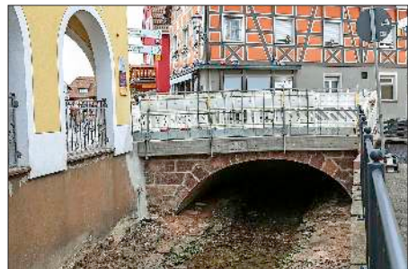
Die Sanierung der Gewerbekanalbrücke in der Friedrichstraße ist abgeschlossen. Fotos: Sandra Decoux-Kone
