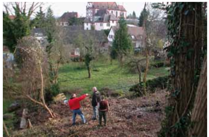
Der Sauersche Garten nach Rodungsarbeiten
