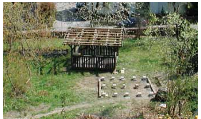
Noch am alten Standort und ohne Ziegel, das neue Fundament davor.
