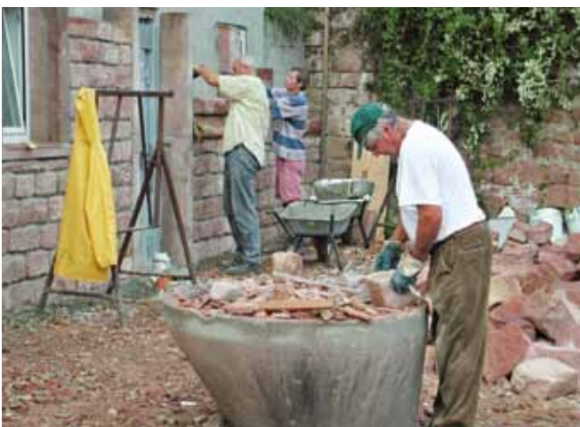
Fassadenverkleidung des Funktionsgebäudes
